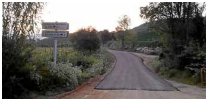
Asfaltatge d'un tram de 700 metres a la carretera de Constantins que dona accés als camins de diverses cases de la zona.
