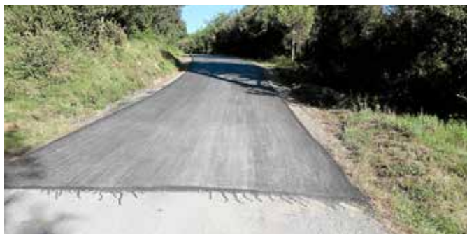
Asfaltatge d'una part del tram de les 4 carreteres a Furgell, fins ara molt malmès per les arrels dels arbres propers a la carretera.
